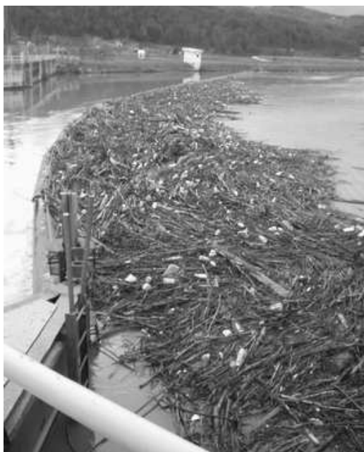
Slika 5: Zastajanje plavja na plavajoči zavesi HE Vrhovo
